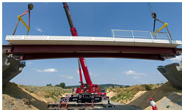
Рисунок 64 — Мостовая конструкция с применением композитов
