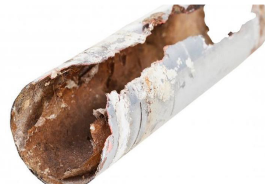
Рисунок 62 – Труба с коррозионными повреждениями
